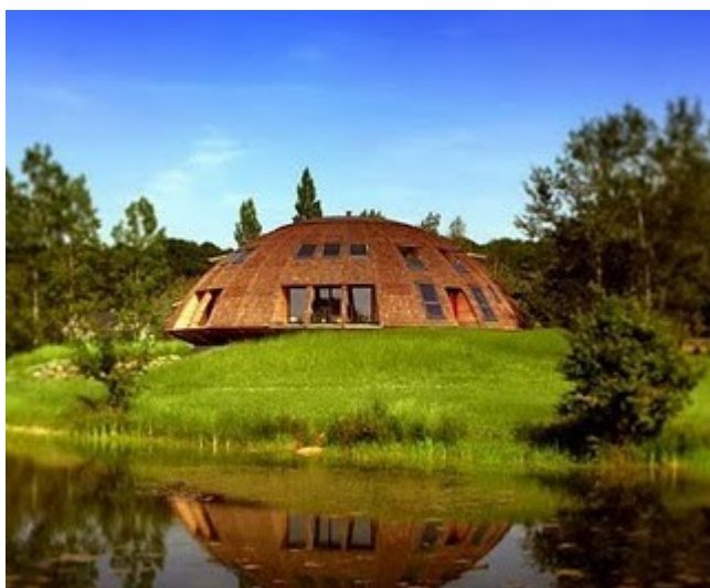
Slika 4: Kupolasta oblika zdrži močnejše potrese ali orkanske vetrove kot katerakoli klasična zgradba primerljivih dimenzij in porabe materiala. Mogoče jo je zgraditi tudi dvignjeno nad terenom. Prikazana izvedba je skoraj povsem iz lesa in se harmonično vklaplja v prostor.
