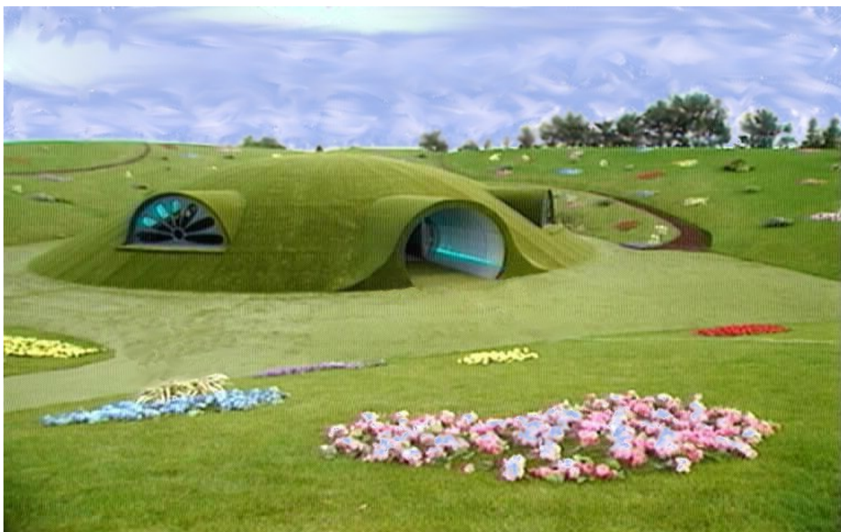
Slika 2: Ni vse, kar je namenjeno otrokom, otročje – statično izredno učinkovita zasnova v kombinaciji z v celoti zatravljeno zeleno streho.
