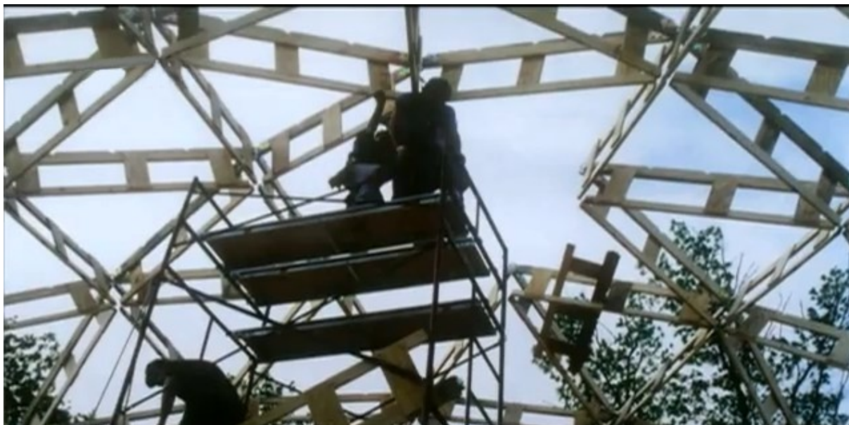
Slika 3: Kljub filigranski konstrukciji se geodezične kupole odlikujejo z nadpovprečno trdnostjo.
